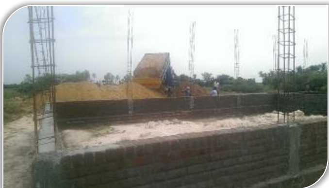
Het fundament van de kerk ligt er al!
